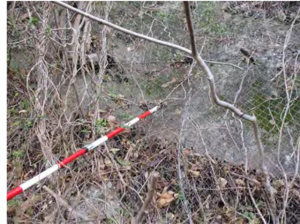
P9 切土斜面の露岩(CL~CM)法面にネット敷設
